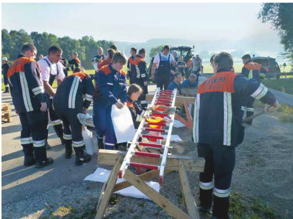
Mitglieder der Feuerwehr Wattenweiler bei der landseitigen Dammverstärkung mittels Kies.
